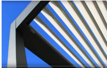
Suppression du préau couvert fixe et son remplacement par une **pergola bioclimatique à lame orientable motorisée et étanche** lorsque les lames sont en position fermée.
