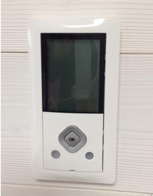
Gestionnaire énergie RT2012 Hager avec indicateur de consommation. Comptage du chauffage, ECS, éclairage, réseau des prises de courant, centrale de ventilation
