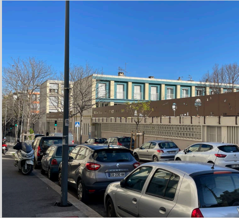
Vue 1 groupe scolaire au nord du site
