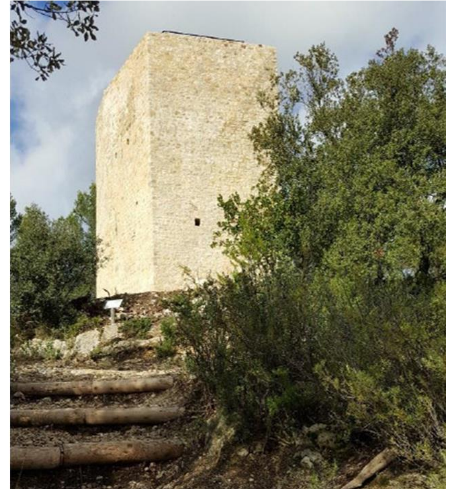
Photo prise en 2017 après les travaux
