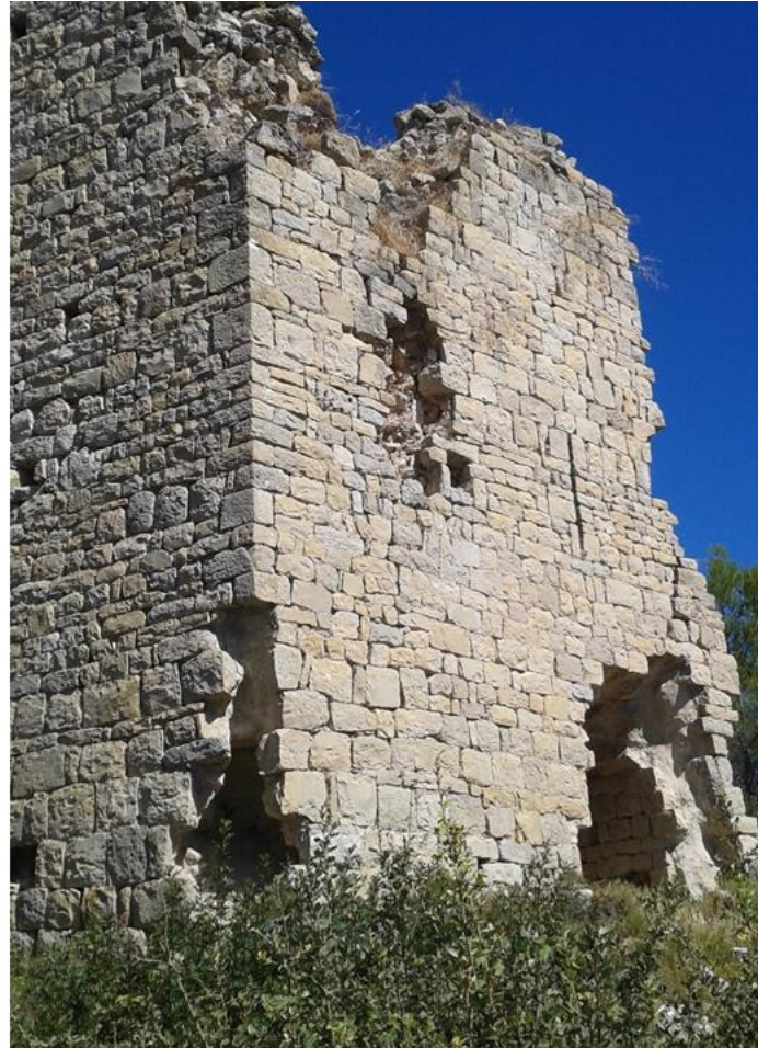
Photo prise en 2015 avant les travaux
