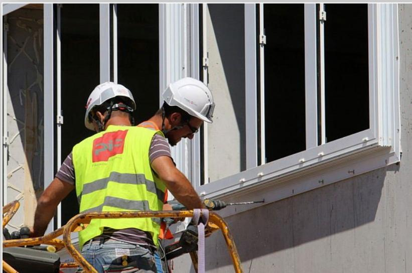
Menuiseries alu DV à rupture de pont thermique, avec limiteur d'ouverture
