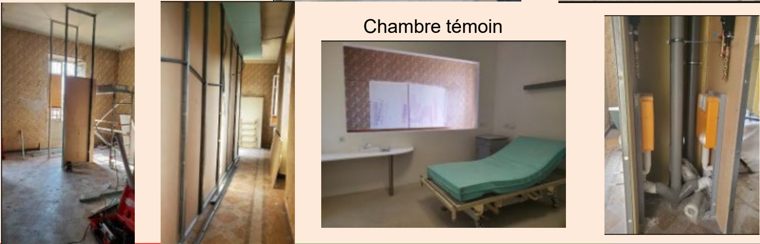
Vérification accessibilité maintenance
