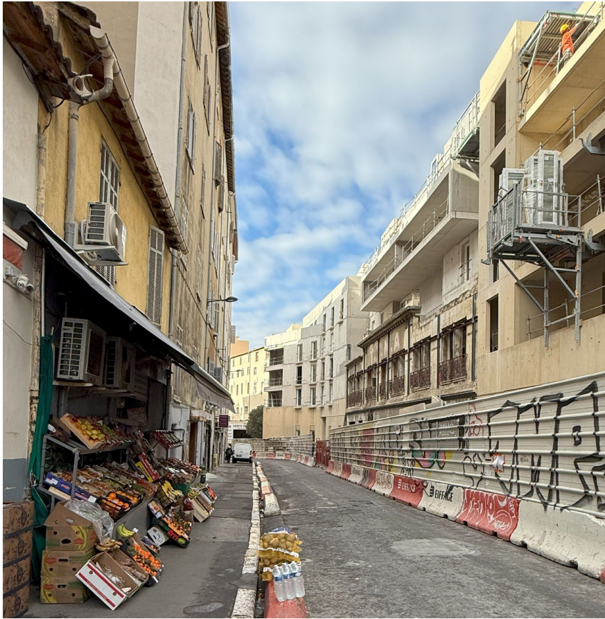
Gros œuvre terminé sur la rue de la Joliette
