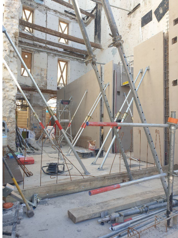
Réhabilitation : Nouveaux planchers, cages d'escalier...
