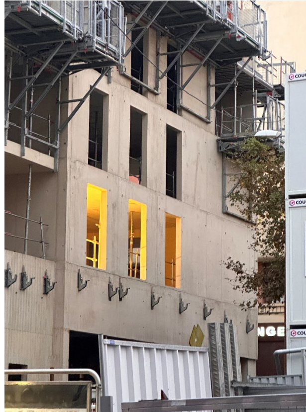
Constructions neuves : élévations en béton bas carbone teinté et matricé
