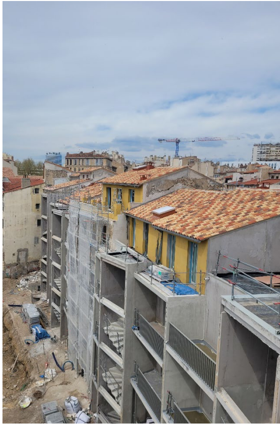
Toiture tuiles (PST)
