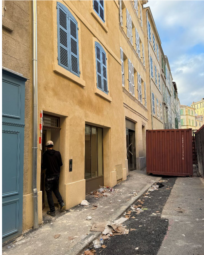
Restauration des façades (pierre, enduits à la chaux)
