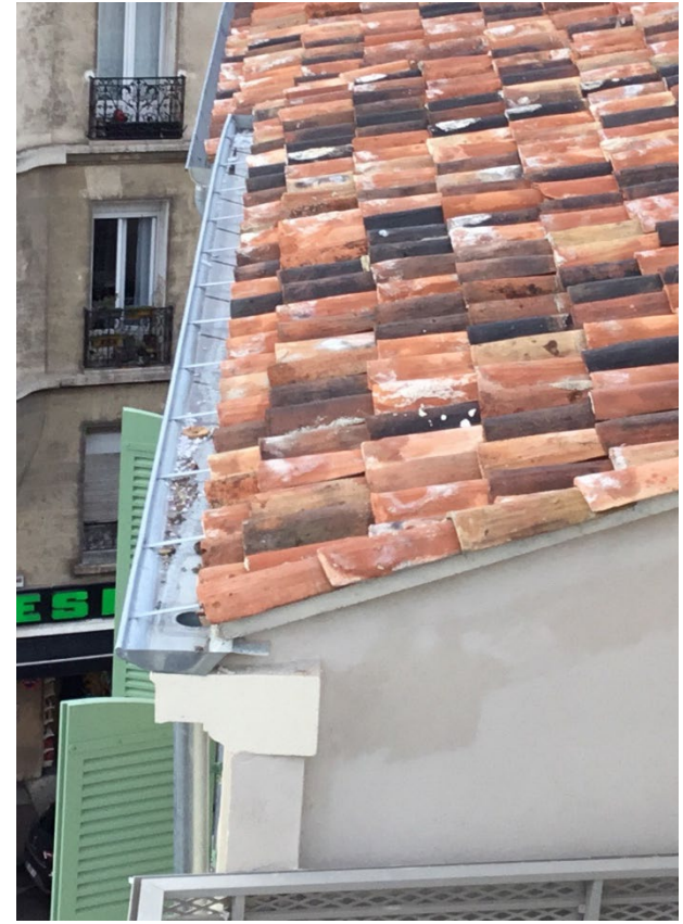
Tuiles réutilisées; posées sur PST
