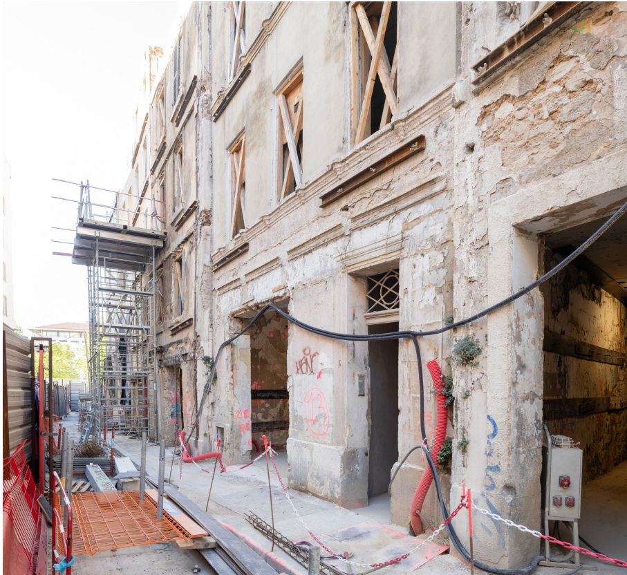
Réhabilitation des façades existantes en pierre
