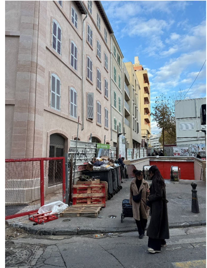
Encadrements et soubassements pierre
