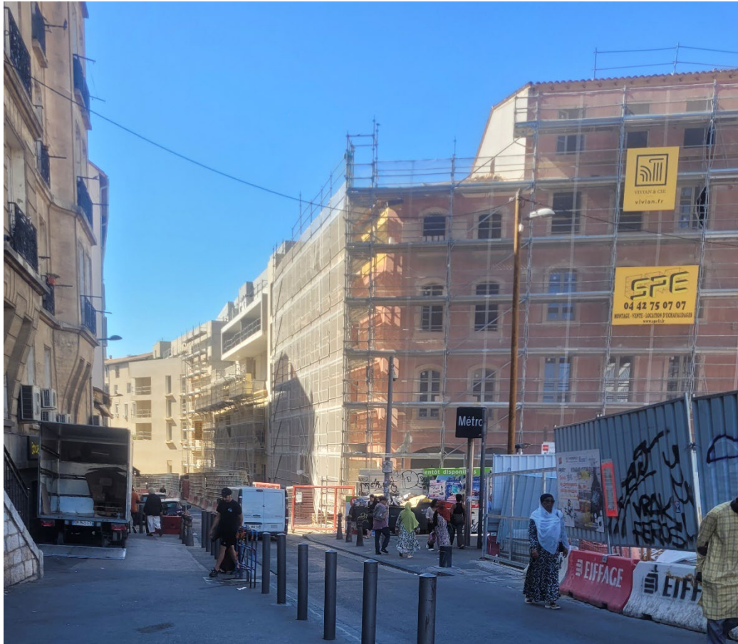
Gros œuvre béton terminé pour les immeubles restitués
