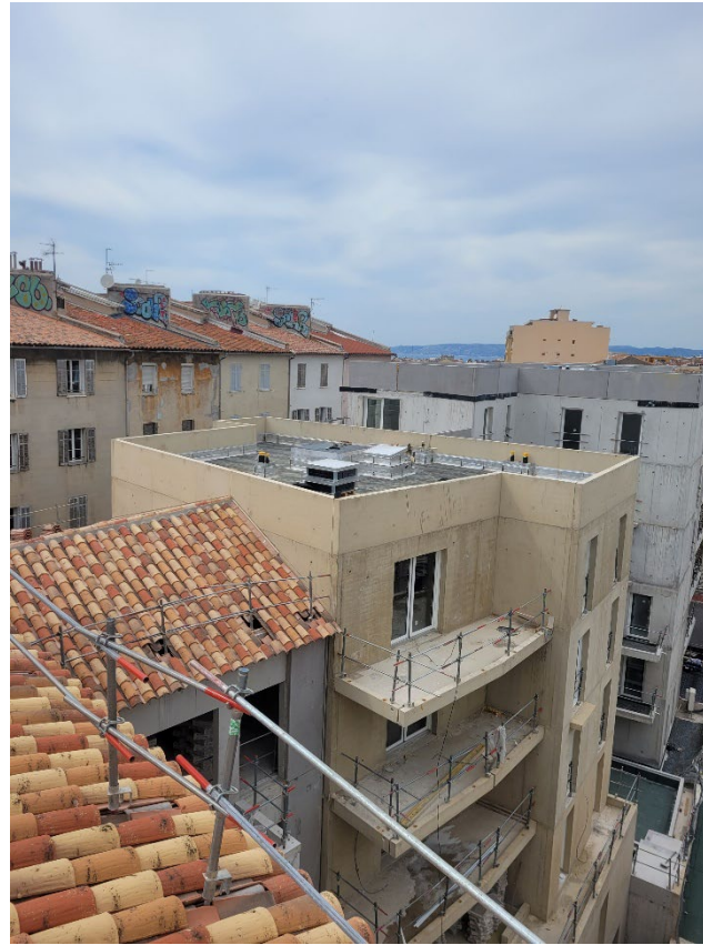
Toiture terrasses à rétention
