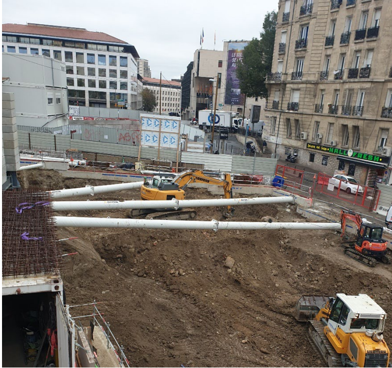
Terrassements, butonnage de la grue et de la façade conservée
