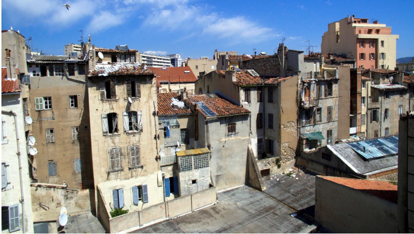
Un cœur d'îlot entièrement bâti ; Des immeubles très dégradés
