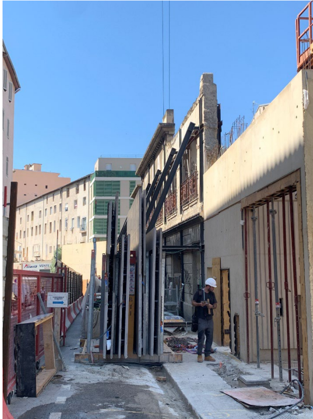
Constructions neuves : élévations en béton bas carbone teinté et matricé
