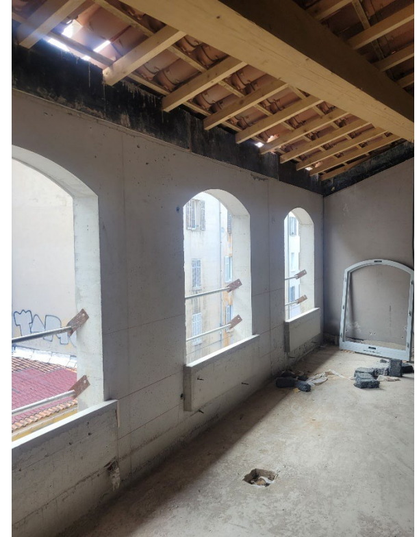
Restitution : Gros œuvre béton bas carbone, charpentes bois
