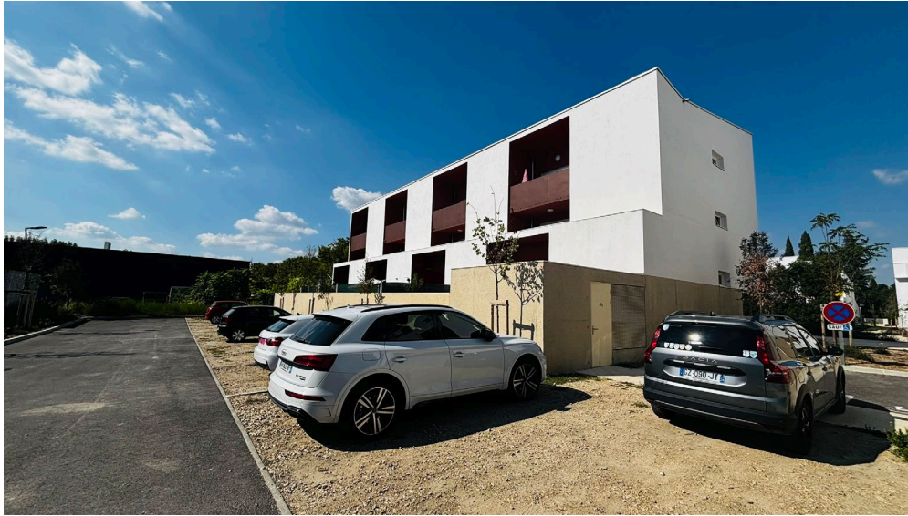
FAÇADES SUD ET EST
