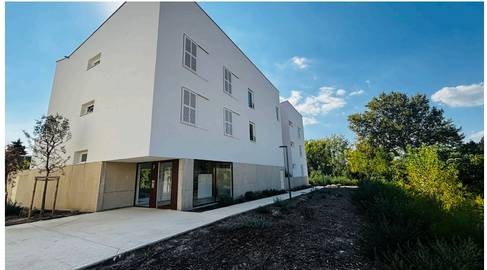
FAÇADES NORD ET EST
