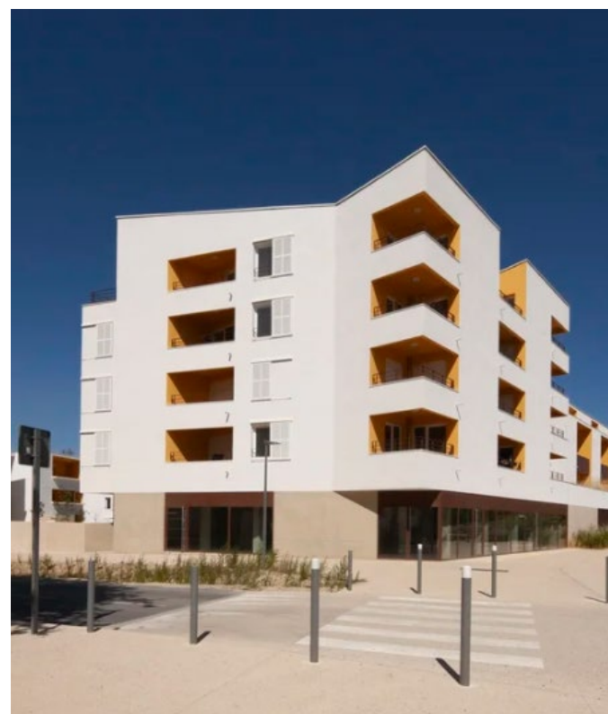
FAÇADE OUEST BÂTIMENT A
