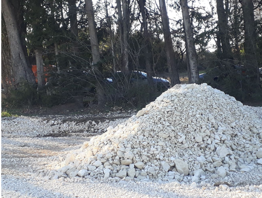
REPLISSAGE DES CHAUSSEES RÉSERVOIR AVEC DU BALLAST LOCAL (au lieu de structures alvéolaires prévues en phase Conception)
