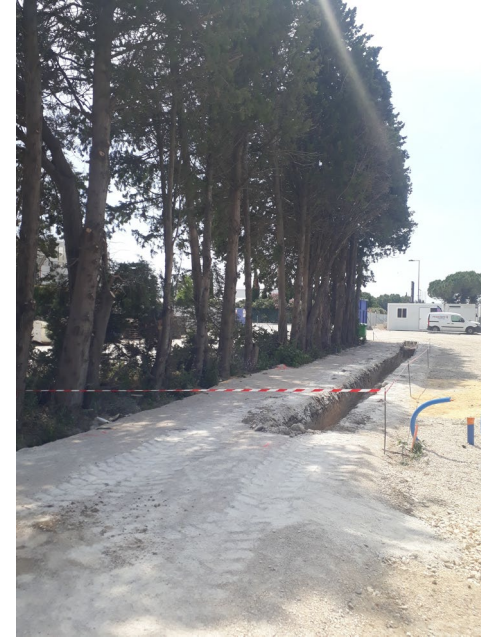
TRANCHÉES POUR RÉSEAU DE CHALEUR
