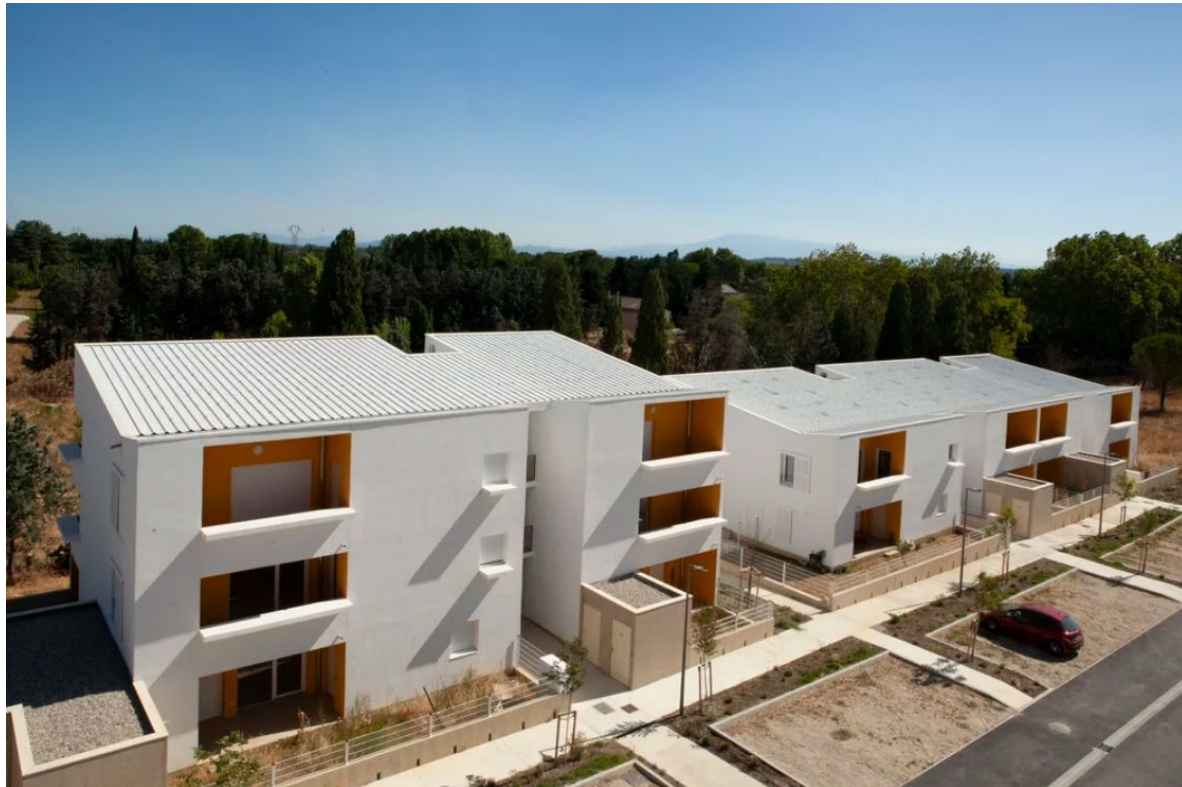
FAÇADES SUD ET OUEST BÂTIMENTS C / D / E
