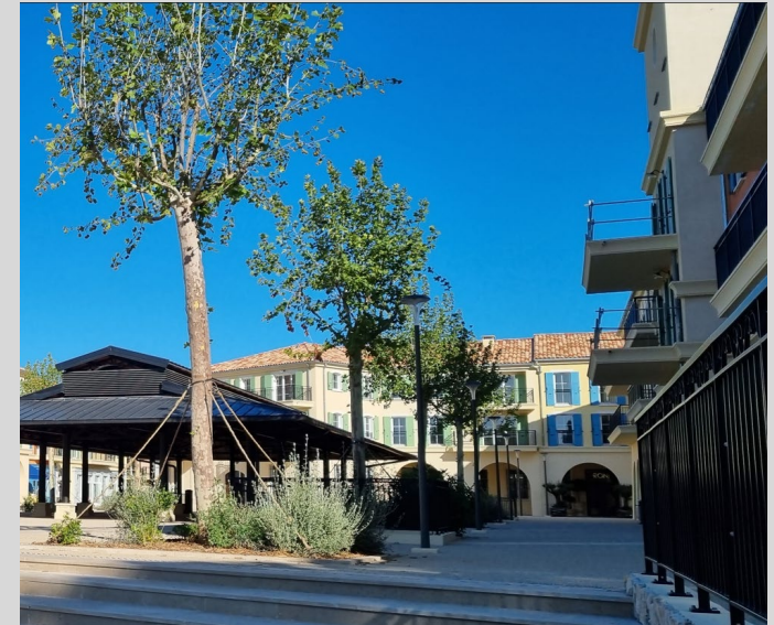
Le Cœur de village - façade Ouest
