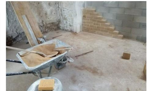
Cloisonnements en BTC – de Brique Technic Concept en 22 (à charge du GO)
