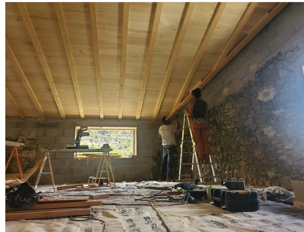
Mise en place ossature bois pour isolation intérieure des murs
