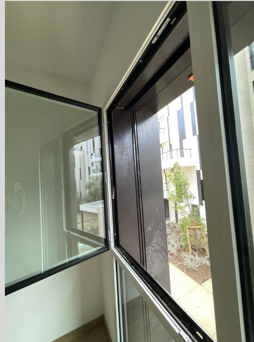
BSO façades Sud
