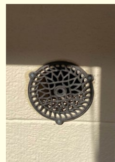
Mise en place d'entrée d'air en façade
