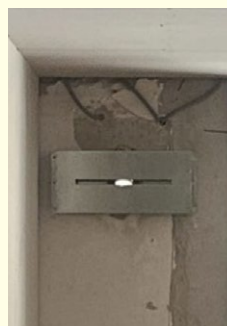
Mise en place d'entrée d'air en façade
