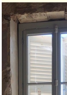
Restauration d'une menuiserie simple vitrage
