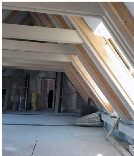
Charpente du niveau aménagé en combles
