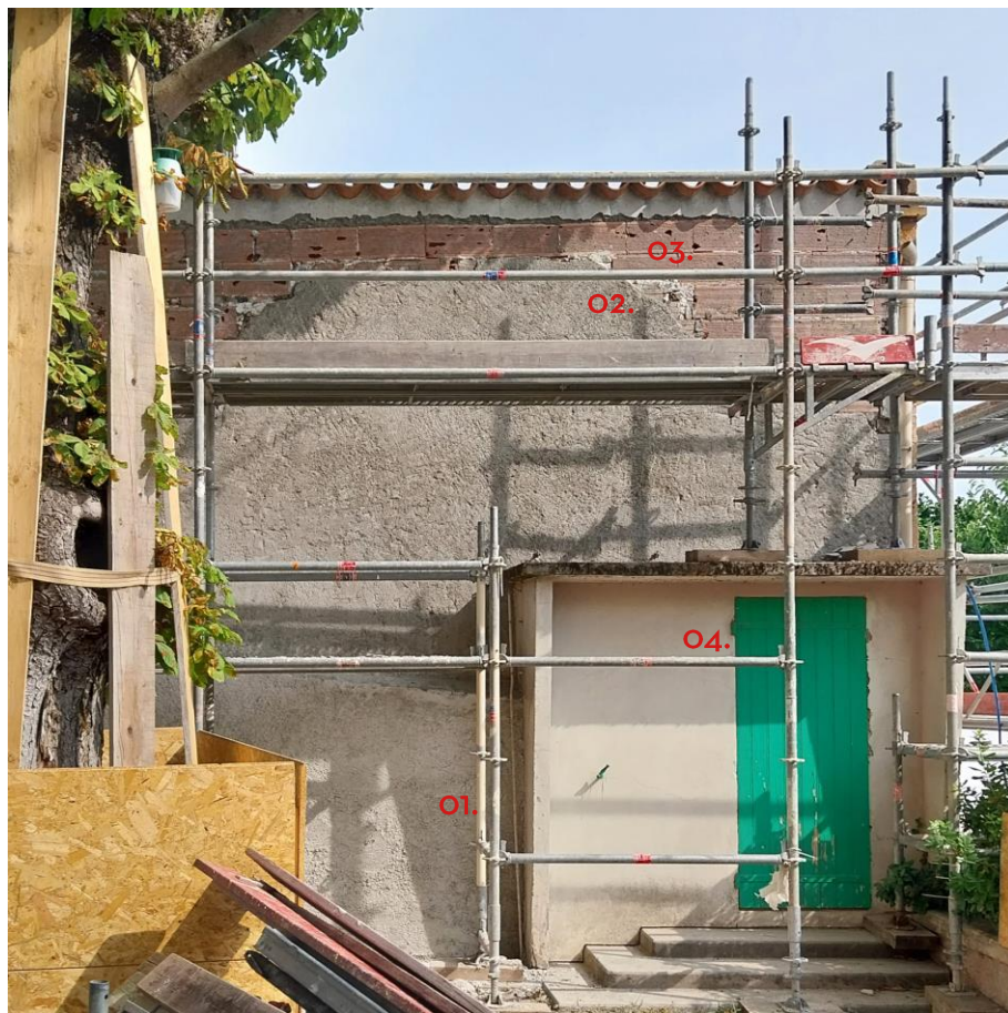
Juin 2025, Sébastien CORD – Photo de chantier
