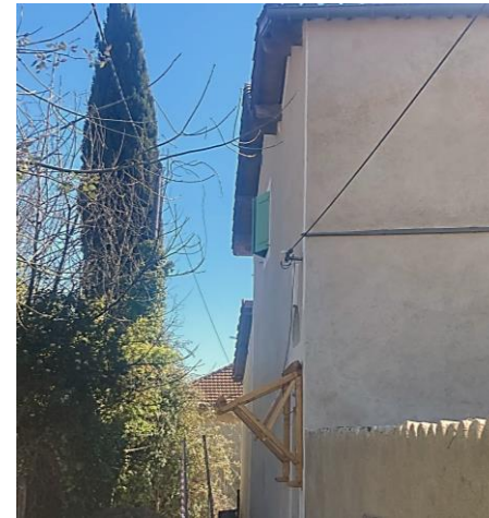
Janvier 2026, Maxime GREGOIRE (Collaborateur) – Photo de chantier
