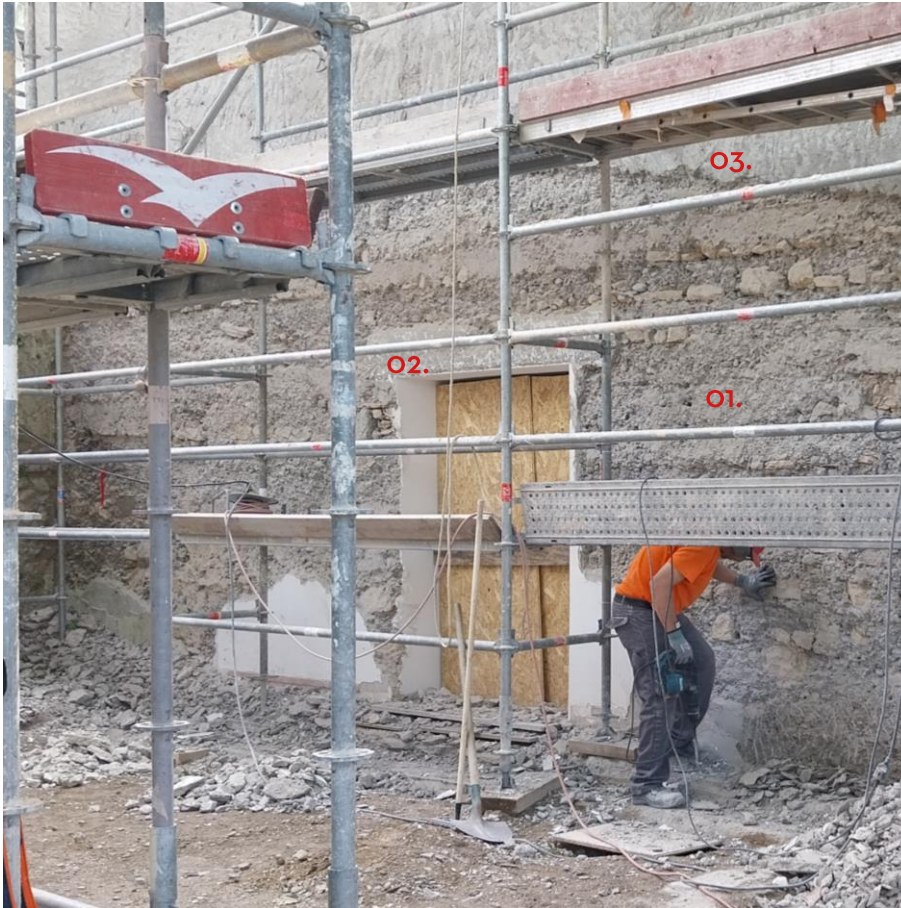
Mai 2025, Sébastien CORD – Photo de chantier
