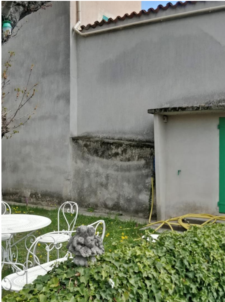
Avril 2022, Sébastien CORD – Etat avant chantier
