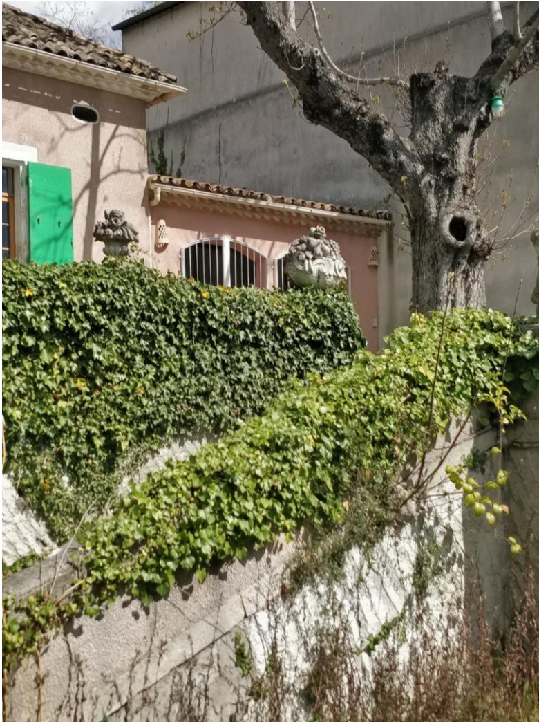
Avril 2022, Sébastien CORD – Etat avant chantier
