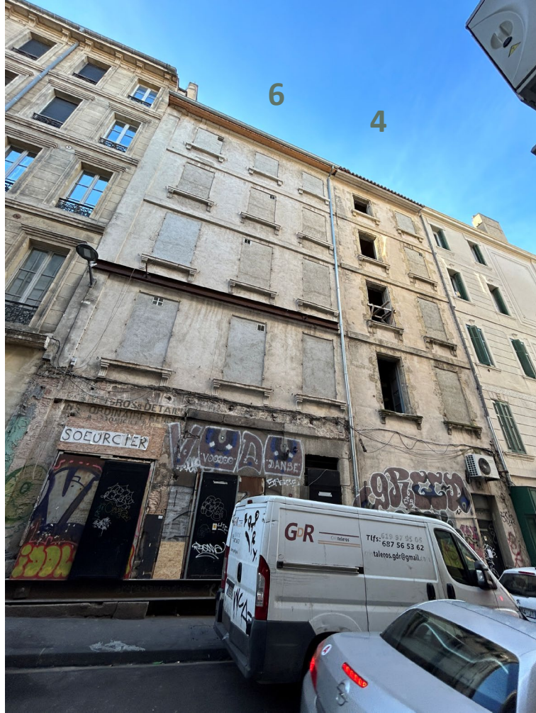
Façades sur la rue Nationale
