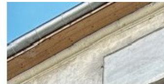
Détail de la corniche
