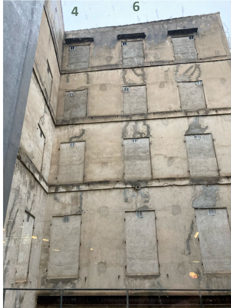
Façades sur cour
