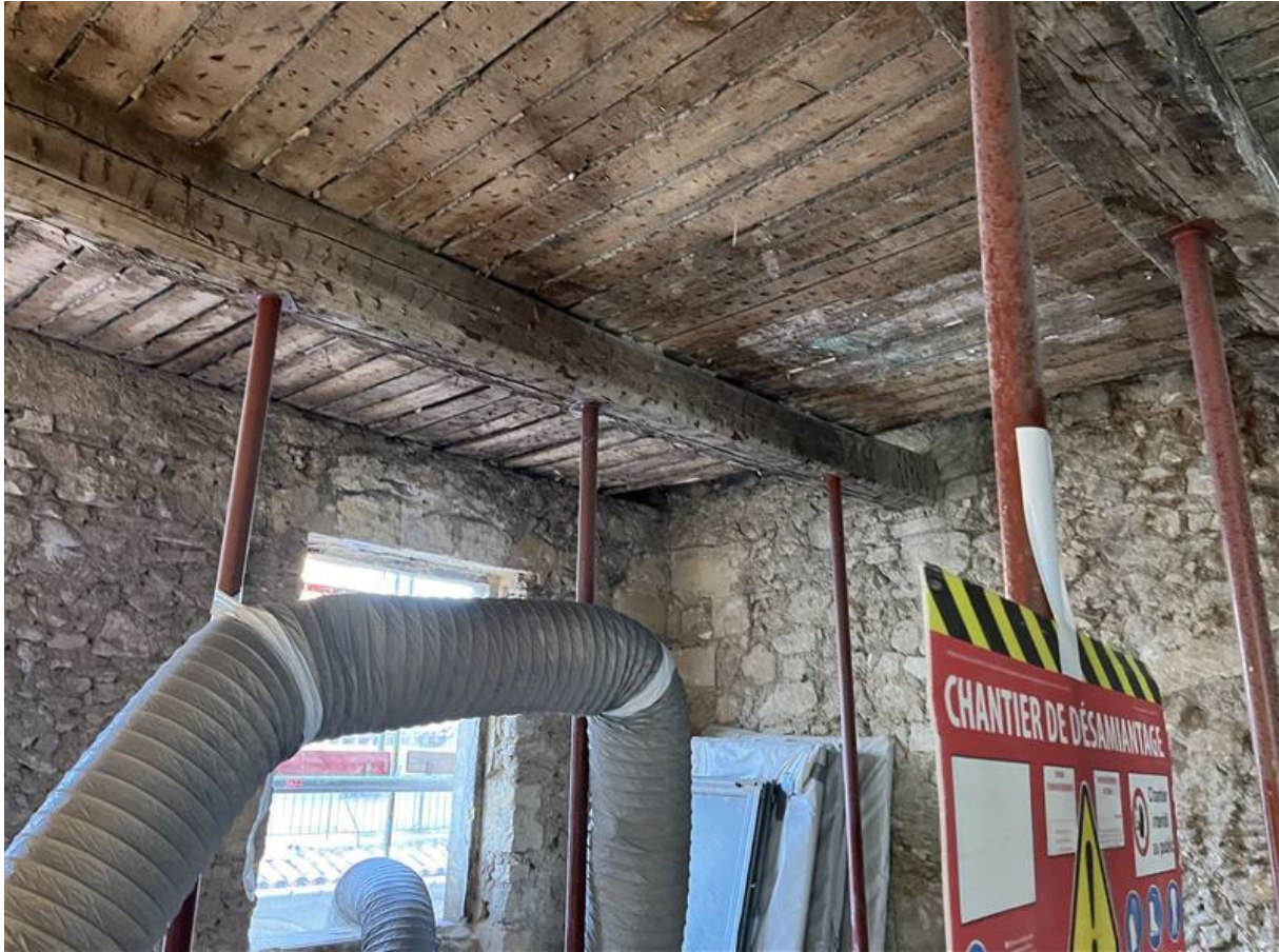
Vue plancher après désamiantage et curage
