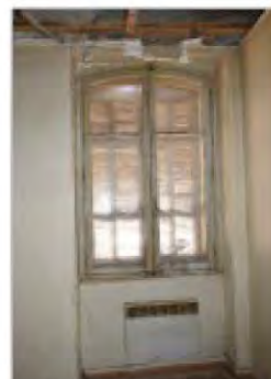
5 - Fenêtres du troisième étage
