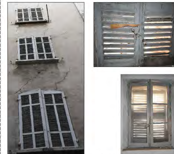
Détails des menuiseries des fenêtres et volets du 40 rue Jean Roque
