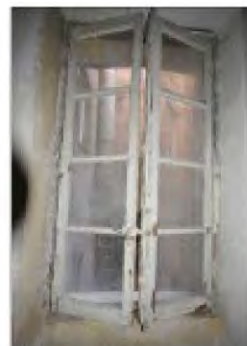
4 - Fenêtres du deuxième et troisième étage
