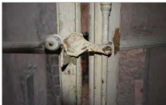
3 - Détail espagnolette d'une fenêtre du deuxième étage
