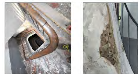
Détails des escaliers de la rue Jean Roque, rue Halle De accroix, rue Sciaffini et rue Kleber
