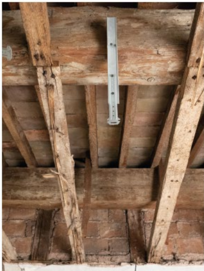
Sous-face toiture R+4
