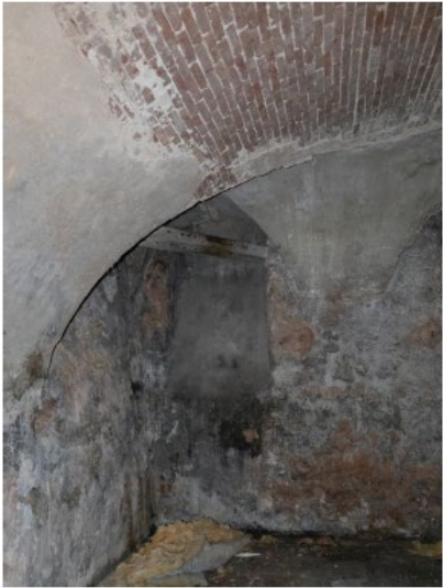
Voûte cave nord
