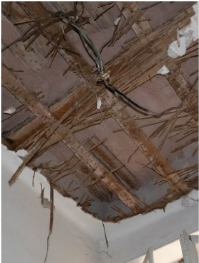
Sous-face plancher R+2
