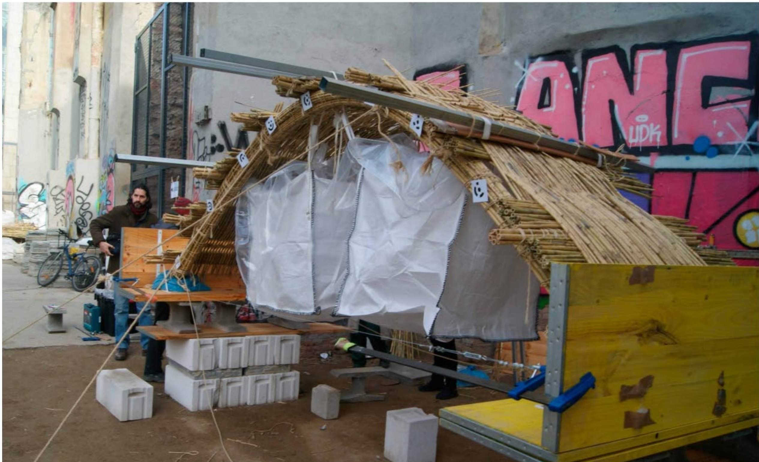
Tests de charge distribués dans le projet Bio Built-Txema, Barcelone. 2014 ©Canyaviva
