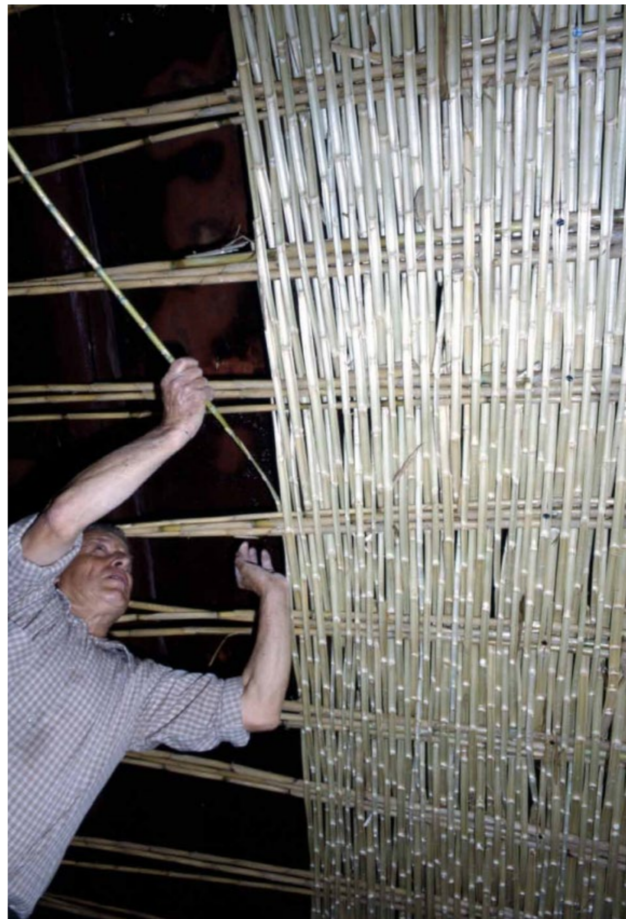
Installation d'un faux plafond en canne tressée par l'artisan Juan Pedrola ©Eugenio Monesma Moliner Pyrene P.V.
