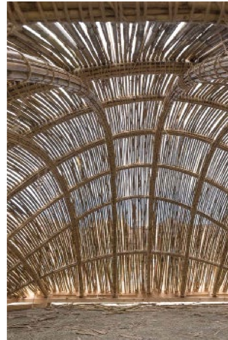
Voûte de roseaux à arcs minces à Can Batlló, Barcelone. 2018. ©Photos et production : Investigació Canyera.
