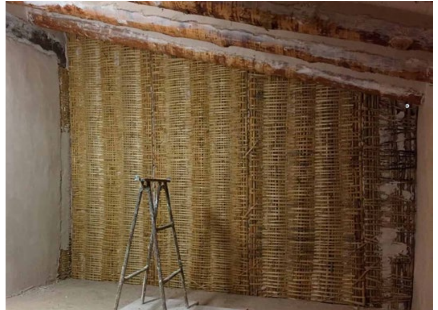
Cloisons préfabriquées en cannes cousues ©Mas de Burot
