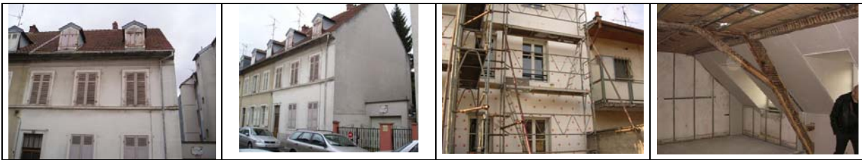
Figure 1.2 : maison du quartier Franklin à Mulhouse, avant et pendant les travaux
