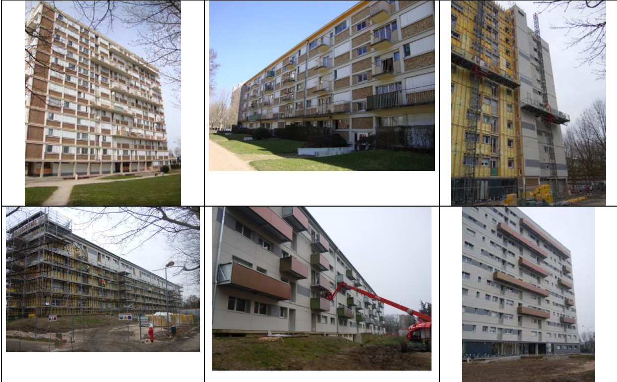
Figure 1.9 : Rénovation de 649 logements sociaux, site des Aubépins, à Chalons s/Saône
