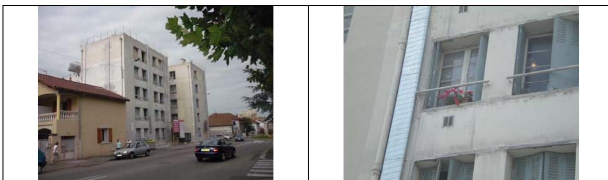
Figure 1.6 : Rénovation de 25 logements sociaux en cours à Bourgoin Jallieu (38)
