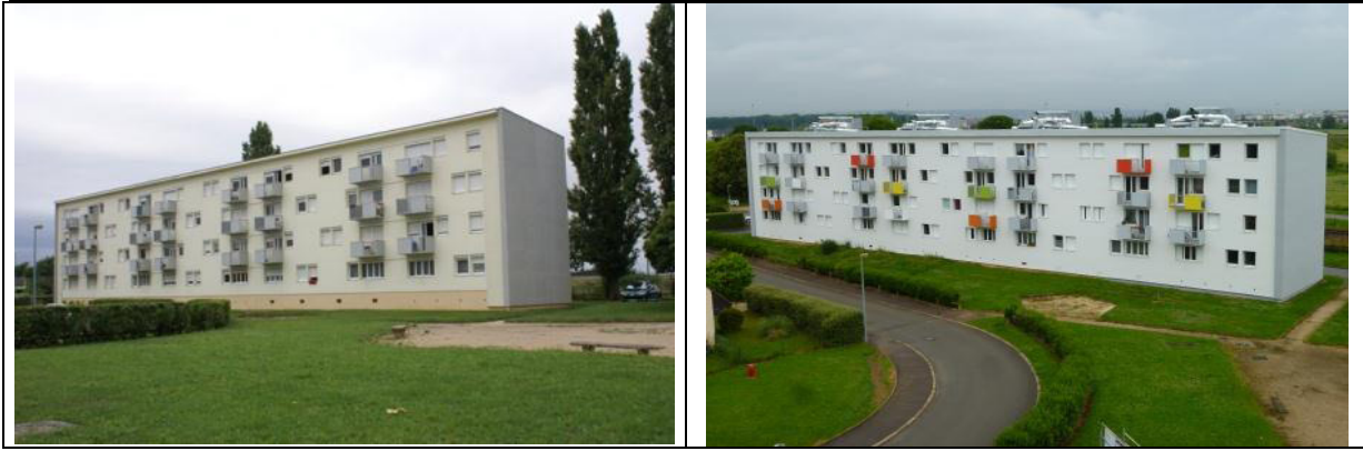
Figure 1.7 : Rénovation de 64 logements sociaux collectifs à Longvic (21)
