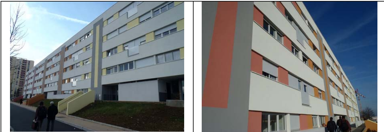
Figure 1.8 : Rénovation de 54 logements sociaux collectifs à Chenove (21)
