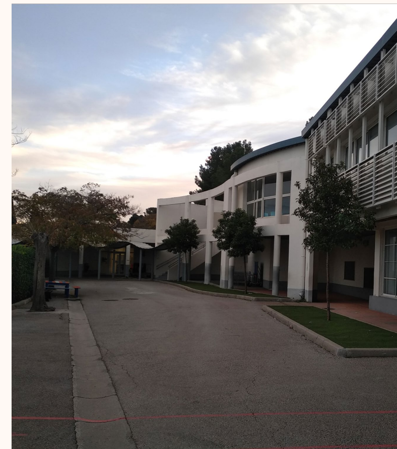
Façade Est, sans protections extérieures
