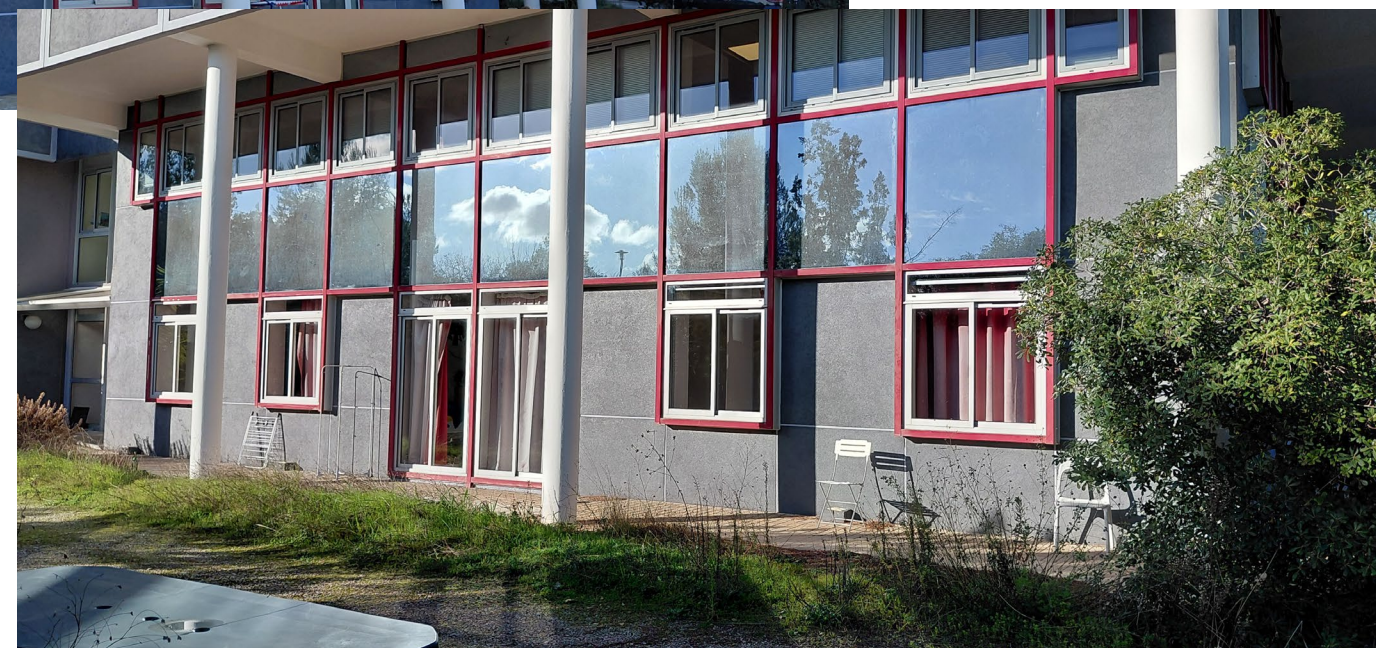
B3E : Façades Est et Sud
