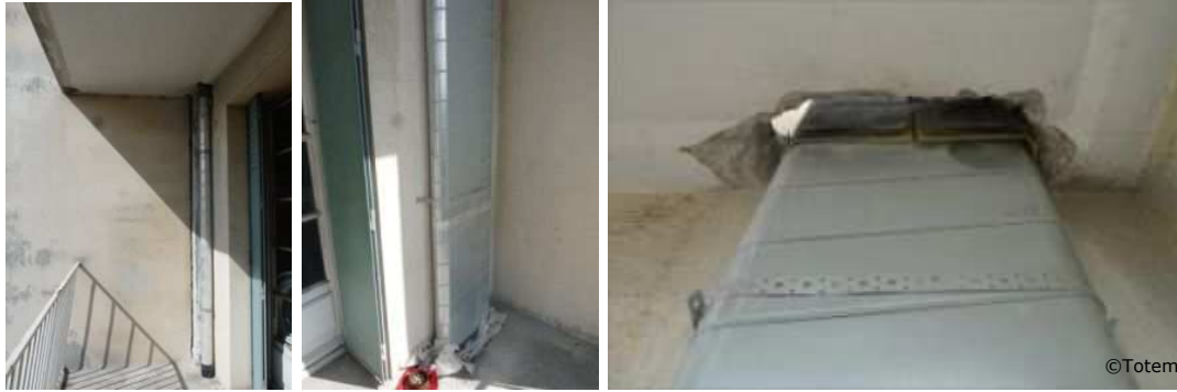
Gaines d'insufflation circulant en façade Ouest, avant mise en place du manteau isolant
