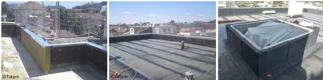
Isolation des acrotères, de la toiture terrasse et du coffre technique
