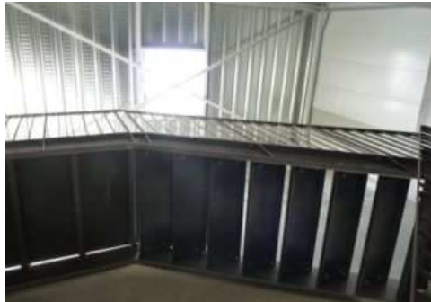
Ouverture de la terrasse pour créer un escalier d'accès à la toiture
