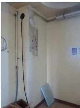
Gaines d'extraction des pièces humides circulant dans la cuisine, puis dans le conduit de fumées existant pour les appartements situés à l'angle des 2 bâtiments
