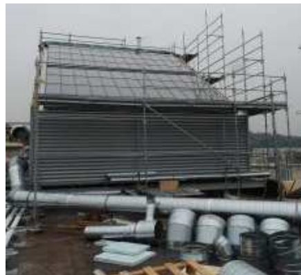
Mise en place de l'installation solaire thermique sur la toiture du local technique (à gauche : août 2010, à droite : octobre 2010)
