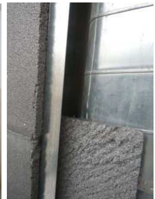
Gaine d'insufflation avec tôles latérales et isolant intérieur
