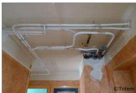
Distribution intérieure du chauffage et de l'ECS dans le hall de l'appartement témoin. Distribution verticale par le conduit du hall
