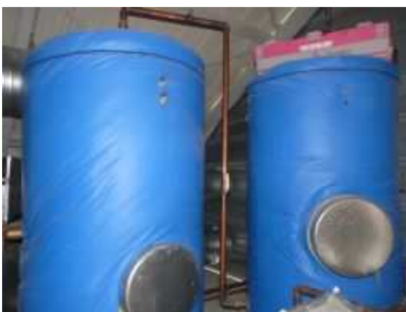
Ballons d'eau chaude sanitaire
