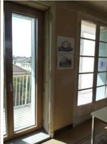
Nouvelle (à gauche) et ancienne (à droite) menuiseries vues depuis le salon
