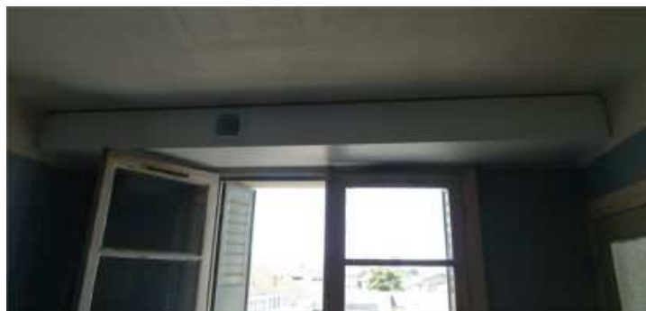
Insufflation dans la chambre à travers un soffite
