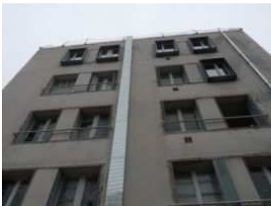
Gaine de ventilation en façade Nord
