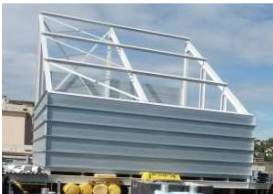
Mise en place de l'installation solaire thermique sur la toiture du local technique (à gauche : août 2010, à droite : octobre 2010)
