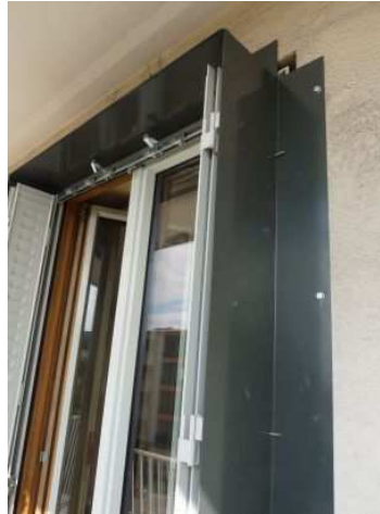
Nouvelle menuiserie, persiennes et précadre, vus depuis le balcon
