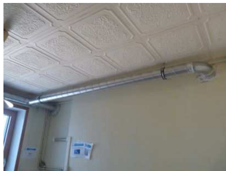
Gaines d'extraction des pièces humides circulant dans la cuisine, puis dans le conduit de fumées existant pour les appartements situés à l'angle des 2 bâtiments
