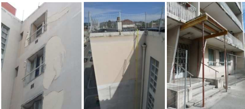
Suppression des encadrements béton des fenêtres et reprises des arêtes au droit des ouvertures
