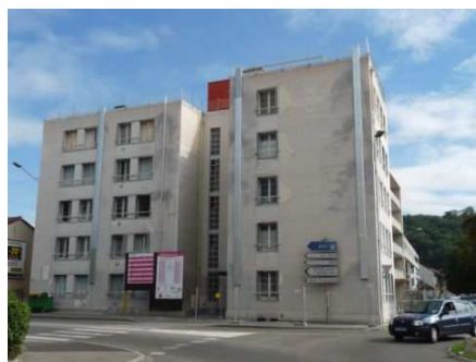
Gainés d'insufflation et d'extraction en façade Nord
