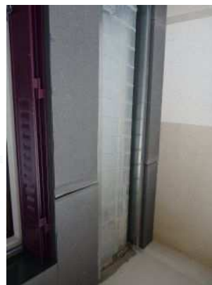
Gaine d'insufflation avec tôles latérales et isolant intérieur
