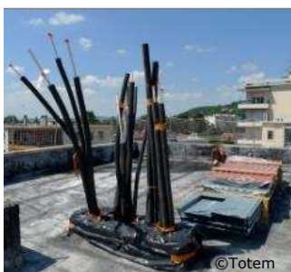
Utilisation des anciens conduits pour passer les réseaux
