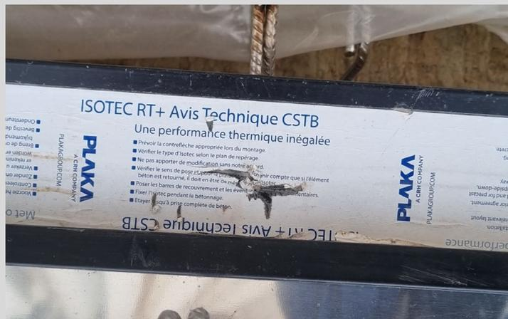
Emploi de rupteur ISOTEC Plaka et de béton thermedia comme rupteur de pont thermique
