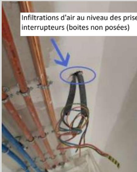
Infiltrations d'air au niveau des prises électriques et interrupteurs (boîtes non posées)
