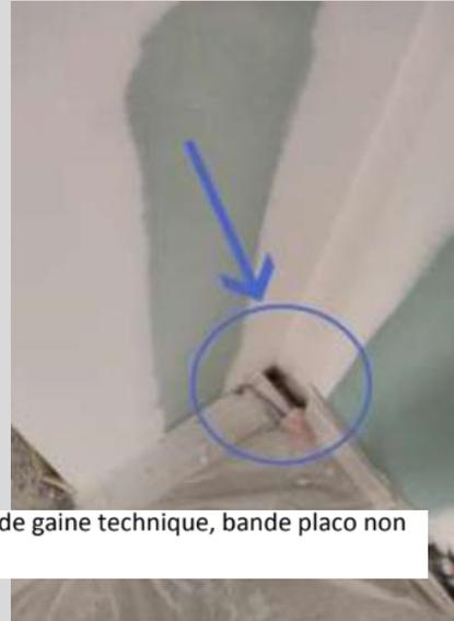
Infiltration en pied de gaine technique, bande placo non réalisé dans l'angle
