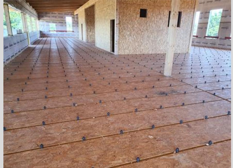
*connecteurs pour plancher mixte bois/béton*
