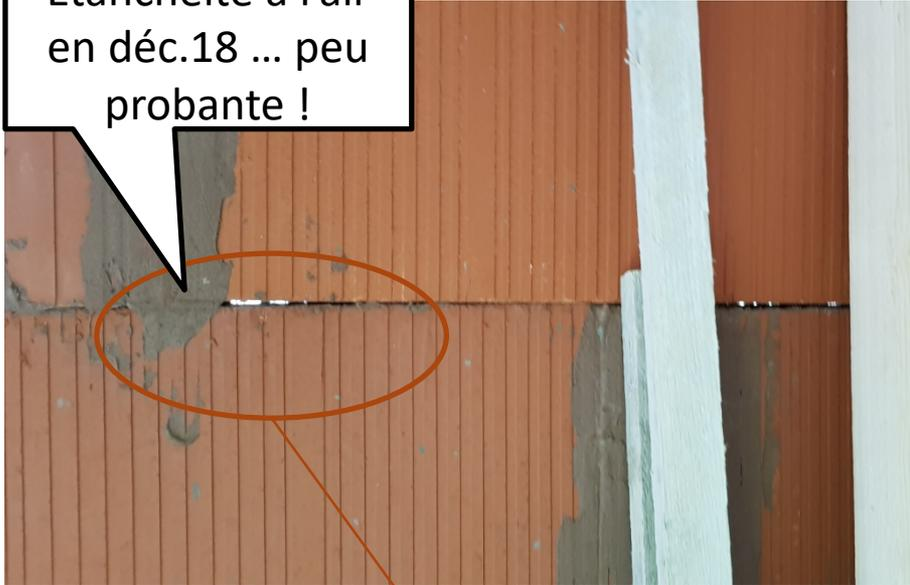
Des tests intermédiaires d'étanchéité à l'air en janv 19 .... très mauvais à **3,88 m<sup>3</sup>/(h.m<sup>2</sup>)** en Q4 Pa-surf
