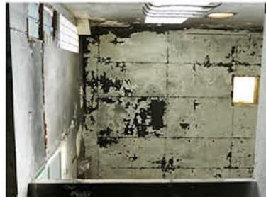
Pénétrations et désordres liés à l'eau sous la toiture terrasse haute. Ouvertures zénithales non bouchées
