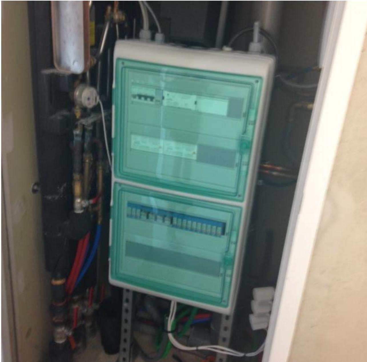
Détail d'une gaine palière: TD + échangeur à plaque sur réseau primaire chauffage pour alimentation ECS des salles d'eau. A échangeur pour 2 chambres.
