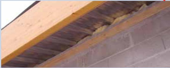
*Pas d'étanchéité de la liaison maçonnerie / bac acier nervuré*
