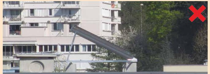
Les supports de fixation des panneaux solaires sont de véritables ponts thermiques
