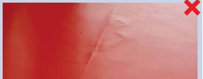
Dégradation à la jonction bord à bord
