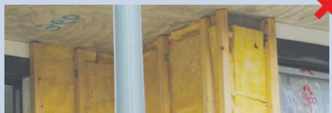
Absence d'isolant en sous-face entre les deux poteaux
