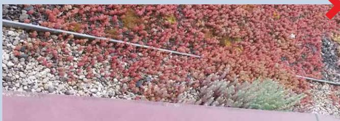
Maintenance sur la bande stérile périphérique non réalisée : risque de perforation de la membrane et des relevés d'étanchéité par les racines
