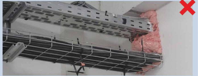
*Etanchéité de la traversée réalisée avec de la mousse expansive*
