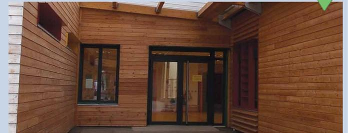
Porte d'entrée fortement sollicitée en châssis tout alu avec rupture de ponts thermiques
