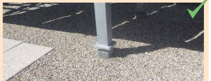
Remontée de l'isolant sur l'ensemble des plots de fixation
