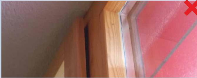
Virille de l'ouvrant sur cette porte fenêtre DV châssis mixte bois alu. Pendant les périodes d'ouverture les contraintes de poids ont déformé la structure de l'ouvrant.
