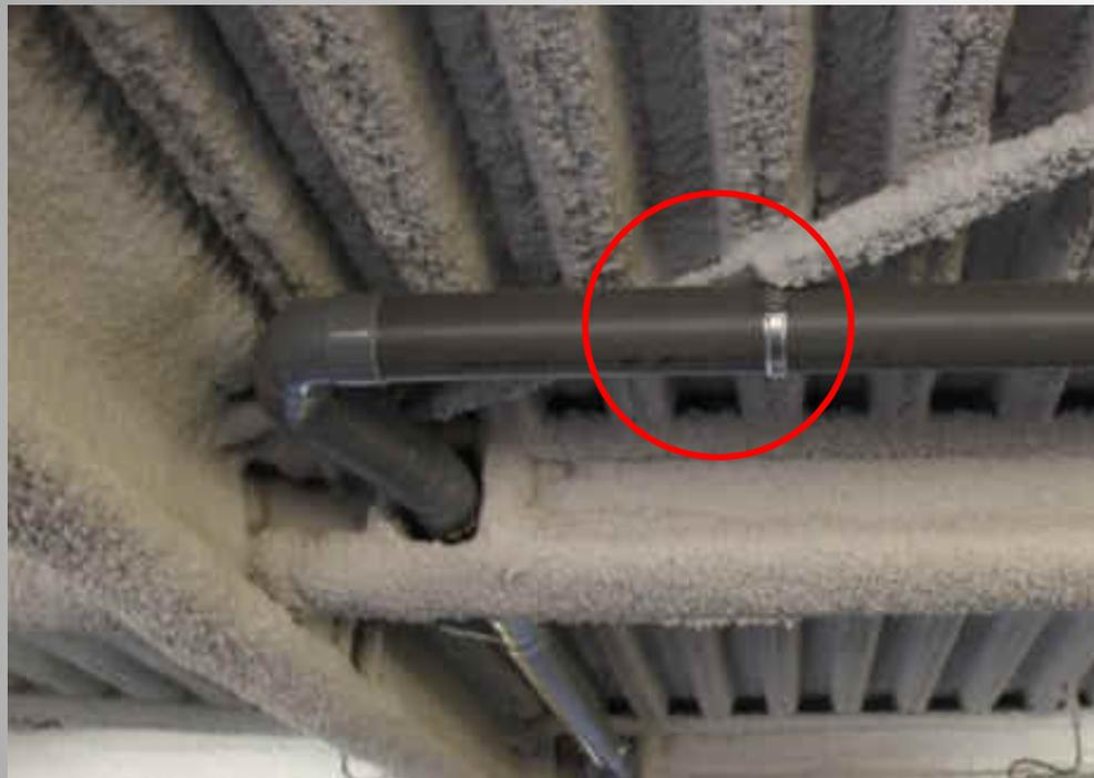
*Collision tuyau d'évacuation - flocage du contreventement du plancher haut*
