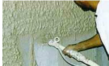
Figure 8 : maxit clima : enduit de plâtre avec Micronal incorporé
