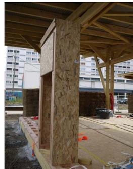
Pour les menuiseries, le tableau et linteau en panneau de bois OSB sont prévus en amont de la pose des bottes.
