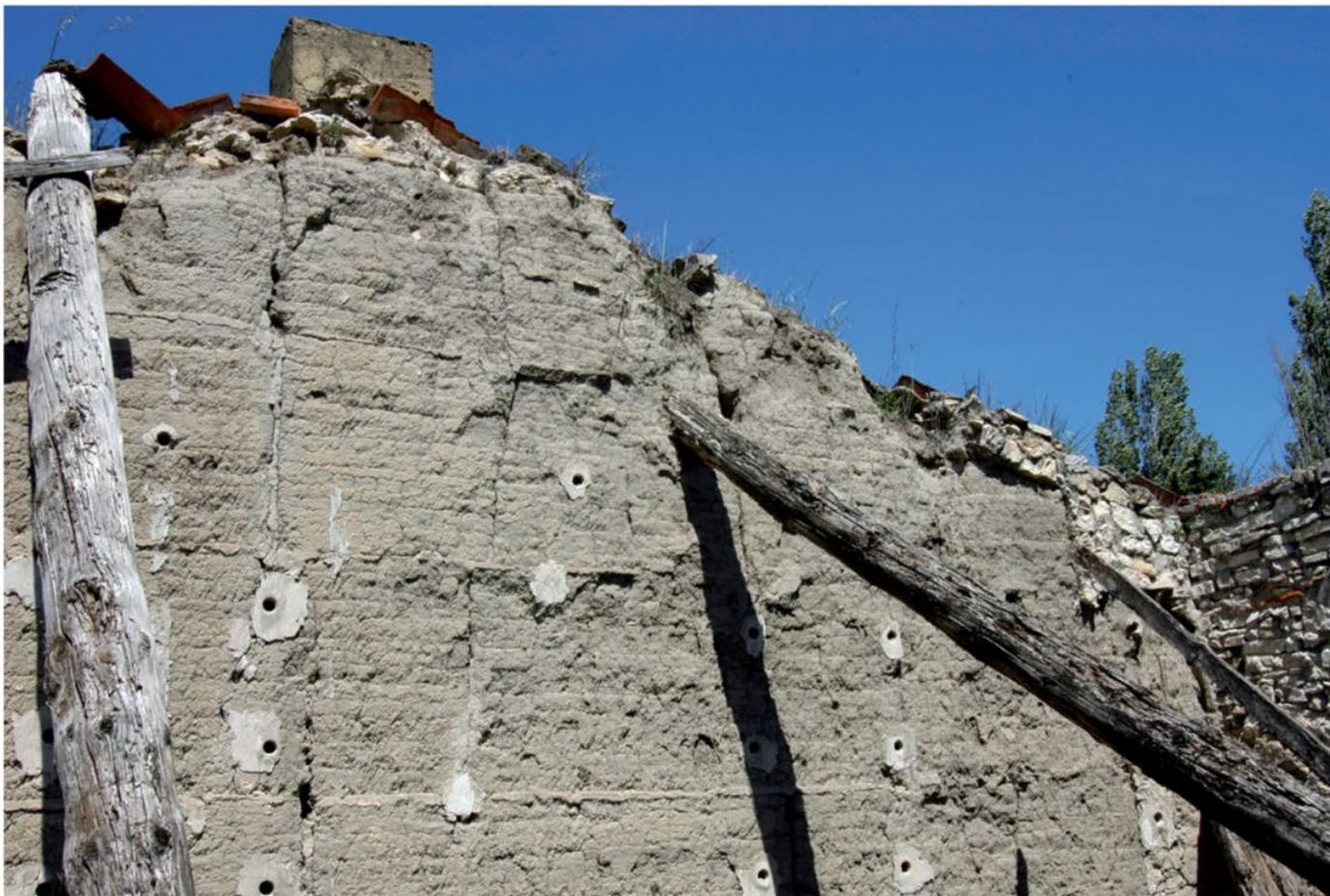
35- L'observation d'un mur en coupe sur une ruine permet d'aboutir à ce constat : le mortier ne pénètre presque pas à l'intérieur du mur.
