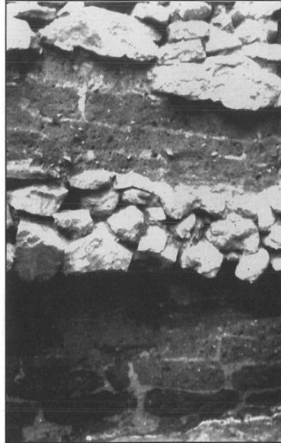
Figure 6 : Mur de refend en briques crues sur solin en pierre, bâti sur un mur arasé, dans l'habitat de l'île de Martigues des V<sup>e</sup>-IV<sup>e</sup> s. av. n. è. (cliché J. Chausserie-Laprée).
