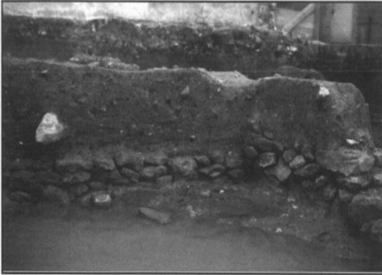
Figure 3 : Angle de deux murs en terre massive (Martigues, milieu du II<sup>e</sup> s. av. n. è.). Celui de gauche est une reprise effectuée par-dessus un mur en brique dérasé (cliché J. Chausserie-Laprée).
