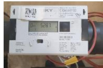
Sous compteurs type Sharky pour réseau chaud / froid (un par zone: highAix / locatif)
