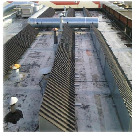
Principe du préchauffage solaire de l'air neuf du gymnase (« solarduct »)
