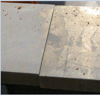
Défaut de pose des couvertines (pas de recouvrement des tôles)
