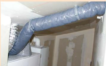
Gaine souple sensible à la diminution de diamètre au niveau des colliers de fixation
