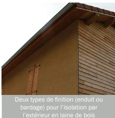
Deux types de finition (enduit ou bardage) pour l'isolation par l'extérieur en laine de bois
