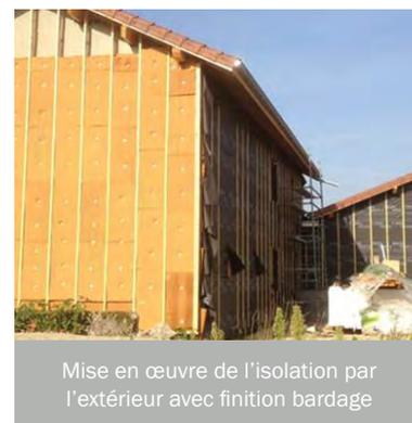
Mise en œuvre de l'isolation par l'extérieur avec finition bardage
