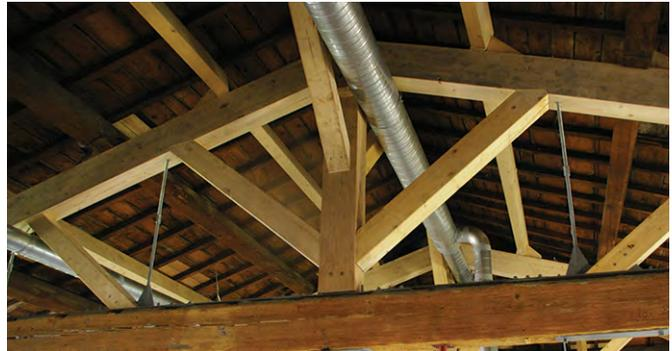
Les reprises de charpente à l'aide de bois lamellé-collé et d'éléments en acier ont permis de conserver les entrants d'origine en bois massif
