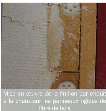
Mise en œuvre de la finition par enduit à la chaux sur les panneaux rigides de fibre de bois
