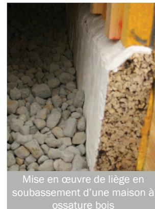
Mise en œuvre de liège en sous-bassement d'une maison à ossature bois
