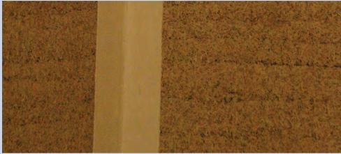
Apparition de moisissures pendant le séchage, laissant des tâches sombres dans les angles notamment. Défaut esthétique rattrapé par un enduit à la chaux.
