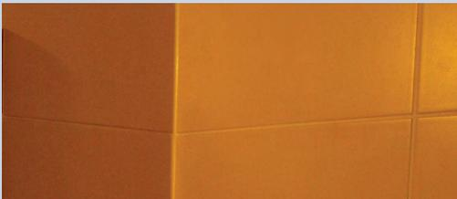
Pose de la faïence sur le béton de chanvre encore humide. Le béton de chanvre observe un retrait en finissant de sécher, les joints ont fissuré et généré un dégât des eaux
