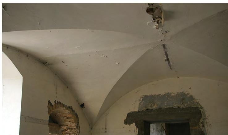
Ponts thermiques créés par les voûtes difficiles à traiter en isolation par l'intérieur
