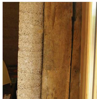
Vue transversale d'un mur intérieur en béton de chanvre banché
