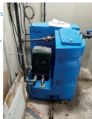
Système gestionnaire des eaux de pluie dans le local technique R-1 du bâtiment A
