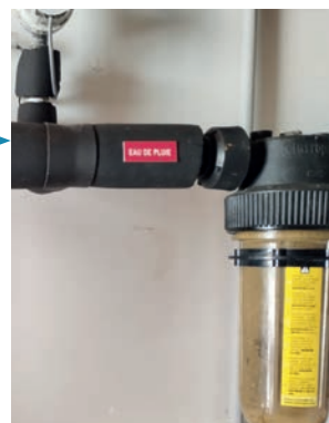
Bon étiquetage et vue du filtre dans le local technique
