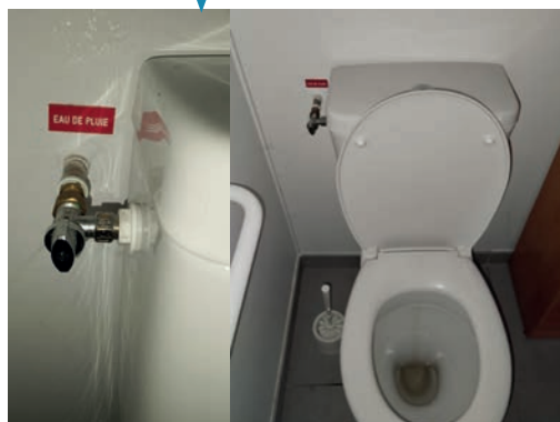
Etiquette gravée à l'arrivée d'eau du réservoir des sanitaires. Turbidité de l'eau visible
