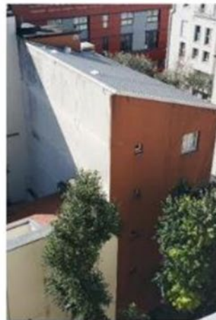
Les façades sont probablement en béton préfabriqué. Des boursouffures et fissures sont à noter au droit des joints, nécessitant le contrôle des modes de fixation.
