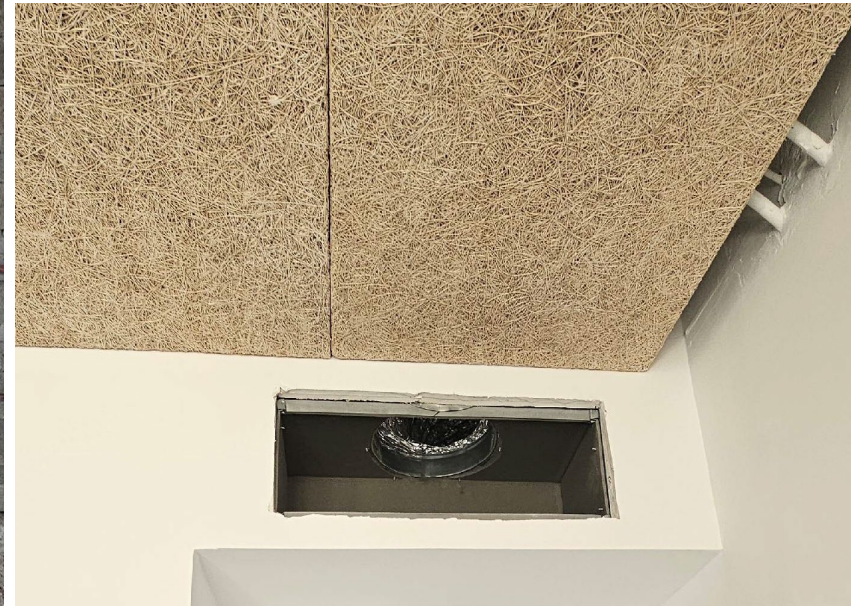
Caisson de détente acoustique en bout de chaque réseau (DOMENE scop)
