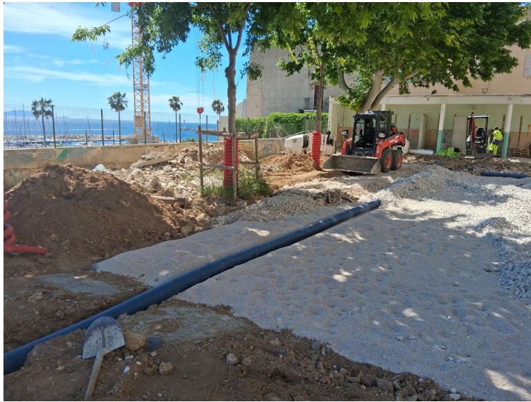
< Réalisation du bassin d'infiltration
