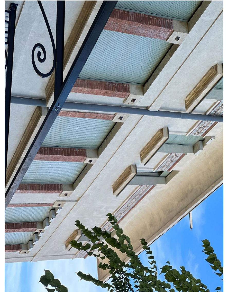
Volets roulants bois restitués (Photo NSL)
