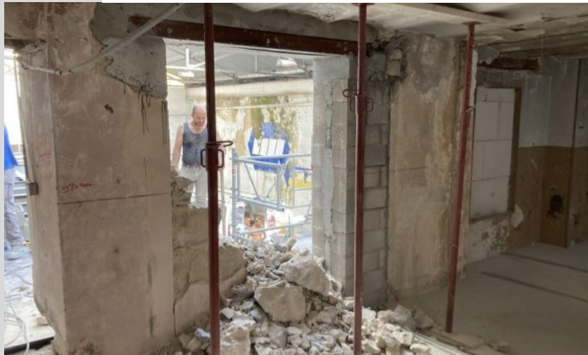
Ouverture en sous œuvre pour passage Mezzanine / Vestiaires – En cours
