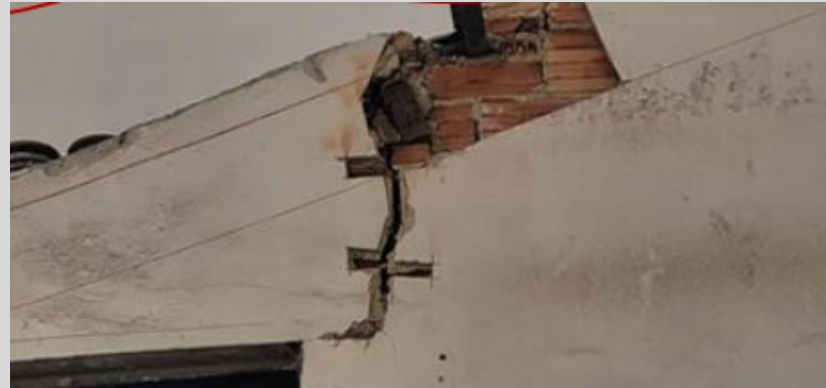
Mise en place d'agrafes pour consolidation du mur
