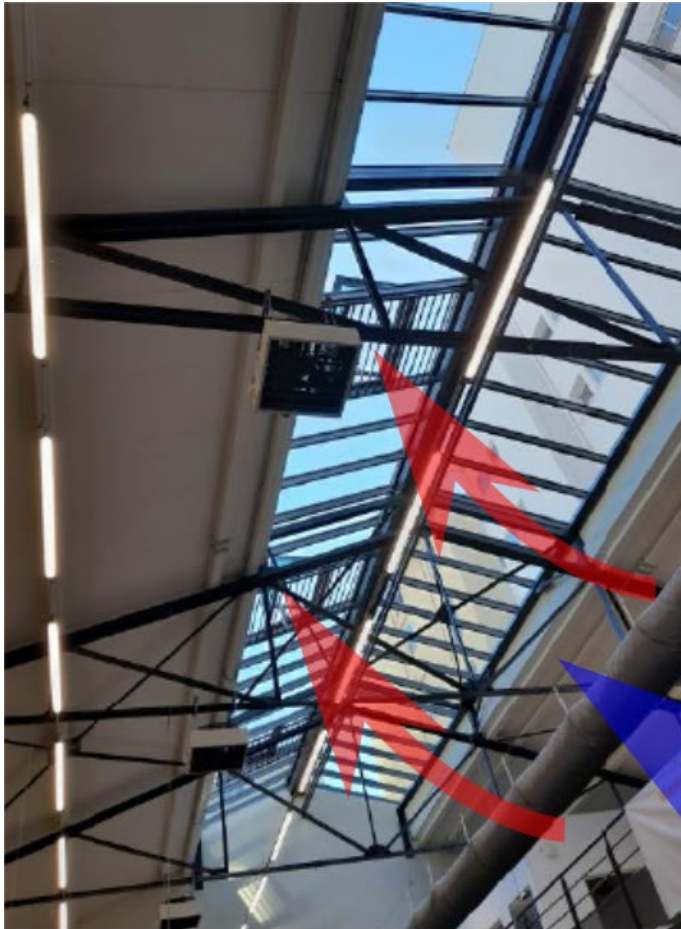
ouvrants motorisés en partie haute de la verrière
