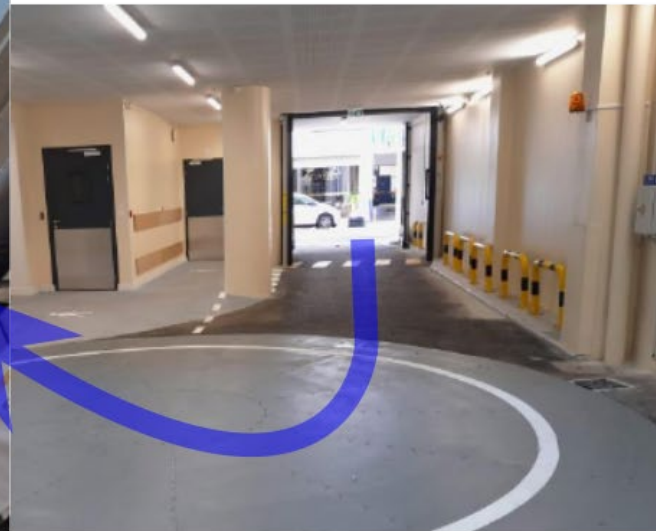
Entrée d'air nocturne avec protection par un rideau métallique ajouré et porte sectionnable ouverte pendant la ventilation
