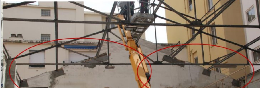
Réalisation des sommiers pour recevoir la charpente sur pignon Est
