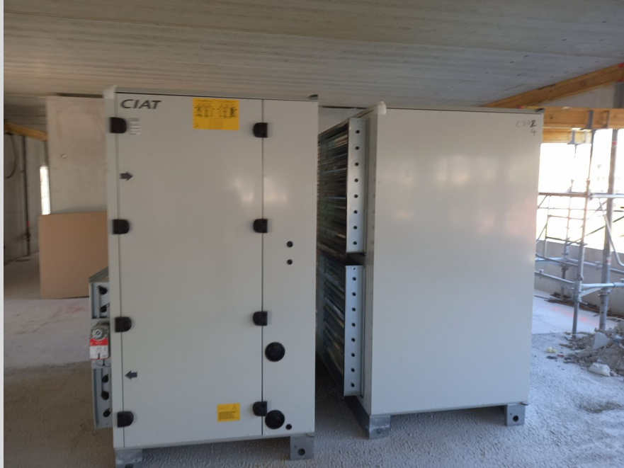
Installation des CTA, des chaudières et des groupes froids
