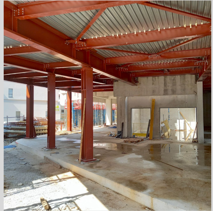
Réalisation du porte-à-faux en charpente métallique
