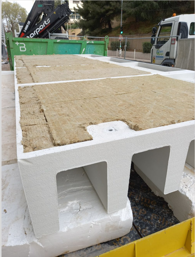
Panneaux BFPU pleins sur voile béton
