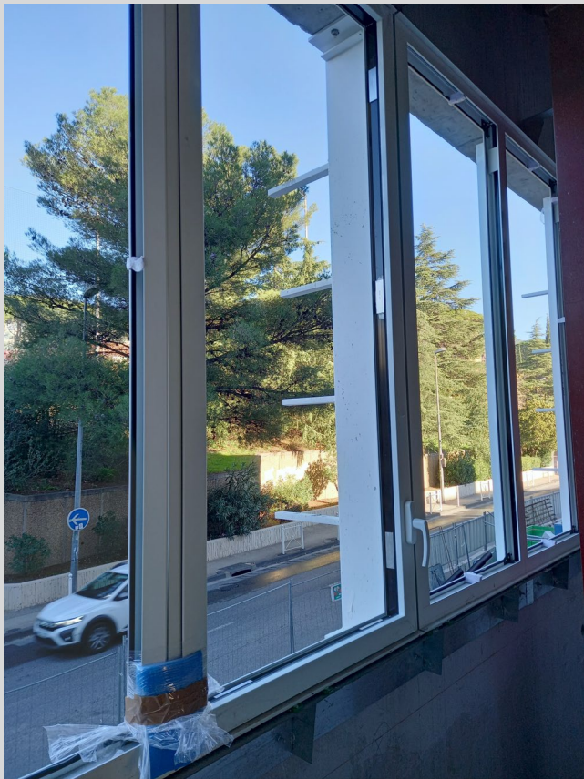
Pose des menuiseries DV
