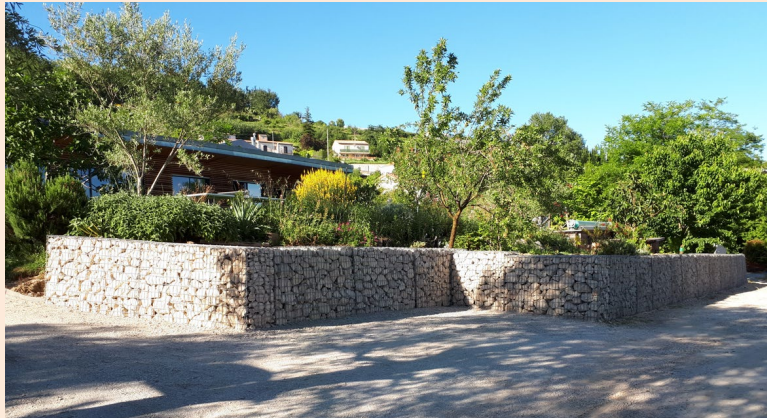
Gabions de soutènement
