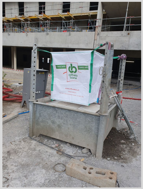
Décantation béton
