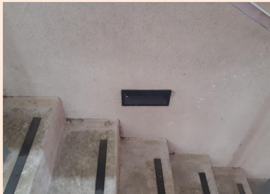
Spots lumineux dans le béton encore en place
