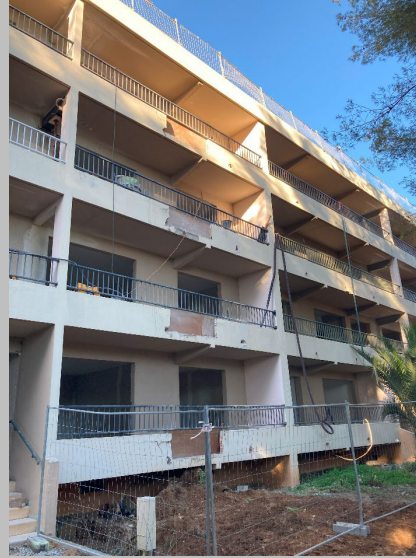
Partie du balcon découpée pour les évacuations.
