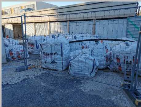
Désamiantage et protection des riverains
