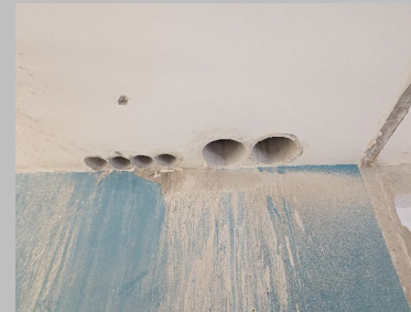
Carottage pour le passage des nouveaux réseaux.
