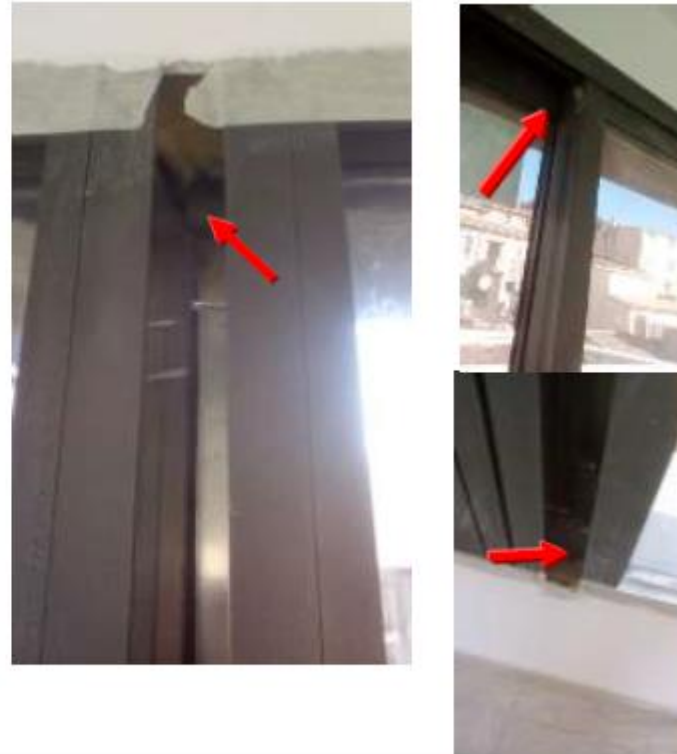
Fuites en périphérie des menuiseries et au niveau du couissant de r+1
