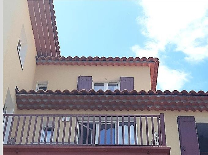
*Toiture tuiles avec génoises en polystyrène*
