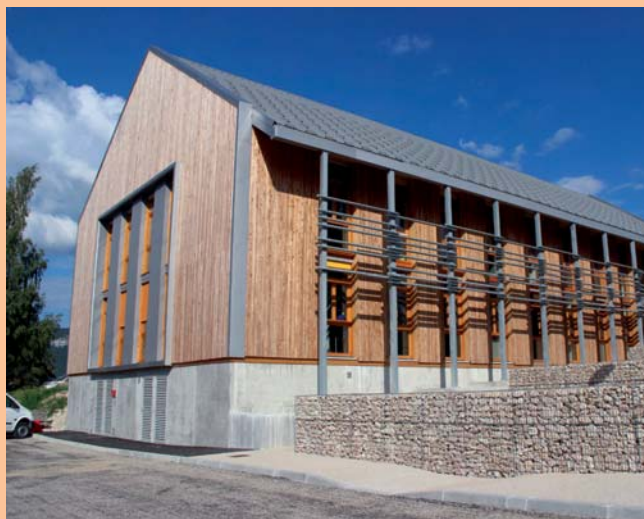
MAISON DU CONSEIL GÉNÉRAL DE L'ISÈRE DE VILLARD DE LANS Bâtiment certifié Bois des Alpes / BRENAS DOUCERAIN
