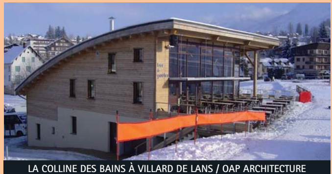
LA COLLINE DES BAINS À VILLARD DE LANS / OAP ARCHITECTURE
