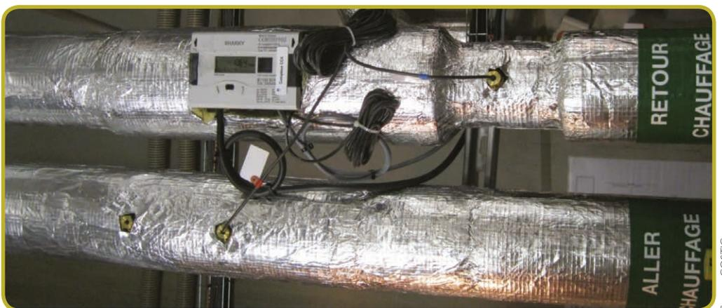
**Compteur d'eau sur le retour, longueurs droites suffisantes, doigt de gant doublé pour comparer les sondes de températures**
