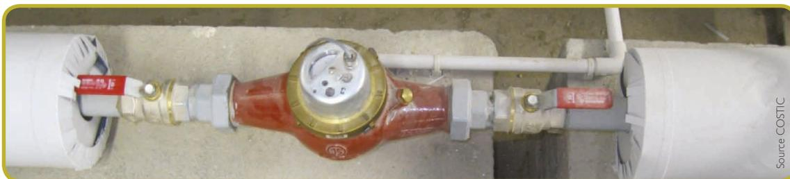
Vannes d'isolement en amont et en aval, compteur placé dans un point bas, à l'horizontale
