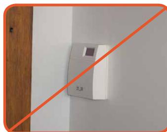
La sonde est dans un coin de la pièce et partiellement masquée par un meuble
