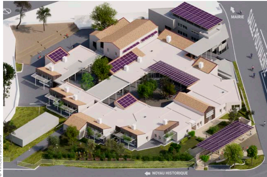
La réhabilitation en site occupé de cette vaste école avec centre de loisirs privilégie le confort d'été comme d'hiver, dedans comme dehors
