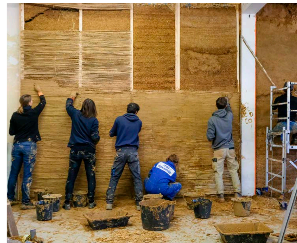
Les enduits intérieurs en terre ont été mis en œuvre dans le cadre d'un chantier participatif.
